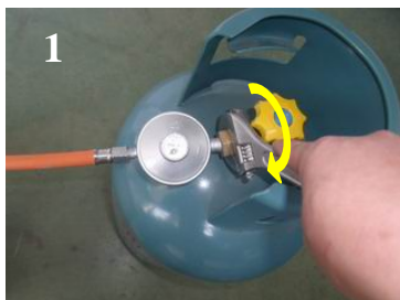
Kiristä liittimen mutteri nuolen osoittamaan suuntaan
